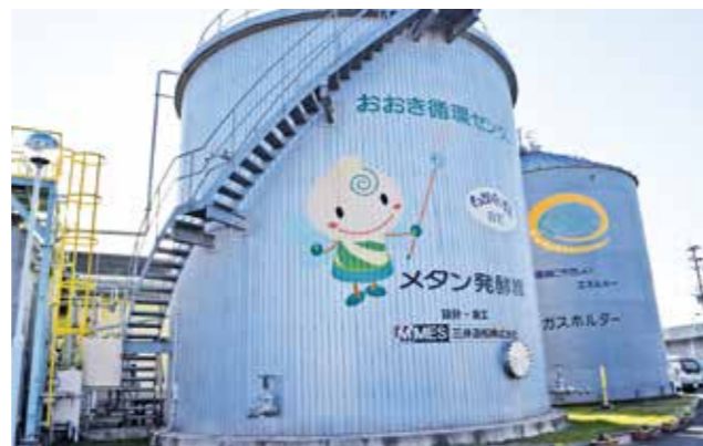
おおき循環センターのバイオガスプラント
