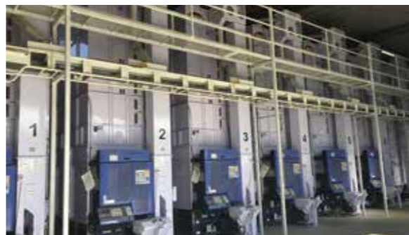
穀物乾燥調製施設内の6基の汎用乾燥機
