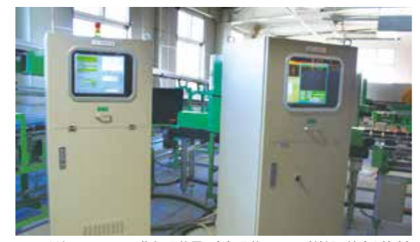
ラインを流れるトマトの画像処理装置と内部品位センサー(外観と糖度を検査)
