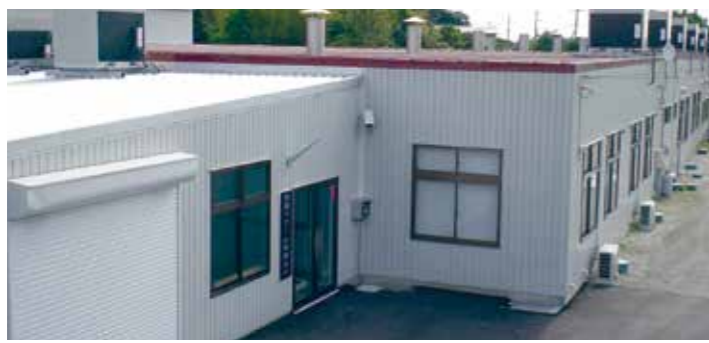
本社・米野井プラント
