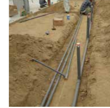
生産者による配管の施工
