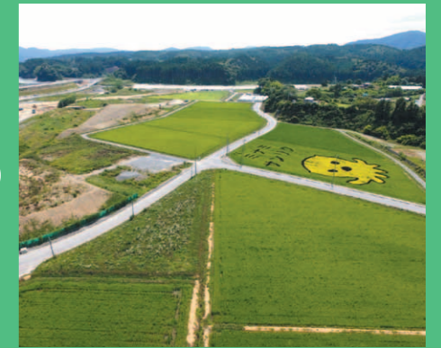
現在(志津川廻館工区) / 撮影日:2015年5月
