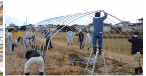
全共連宮城県本部職員によるイチゴパイプハウス解体作業
