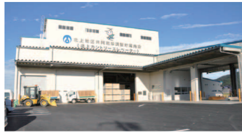
整備された北上カントリーエレベーター(JAいしのまき)
