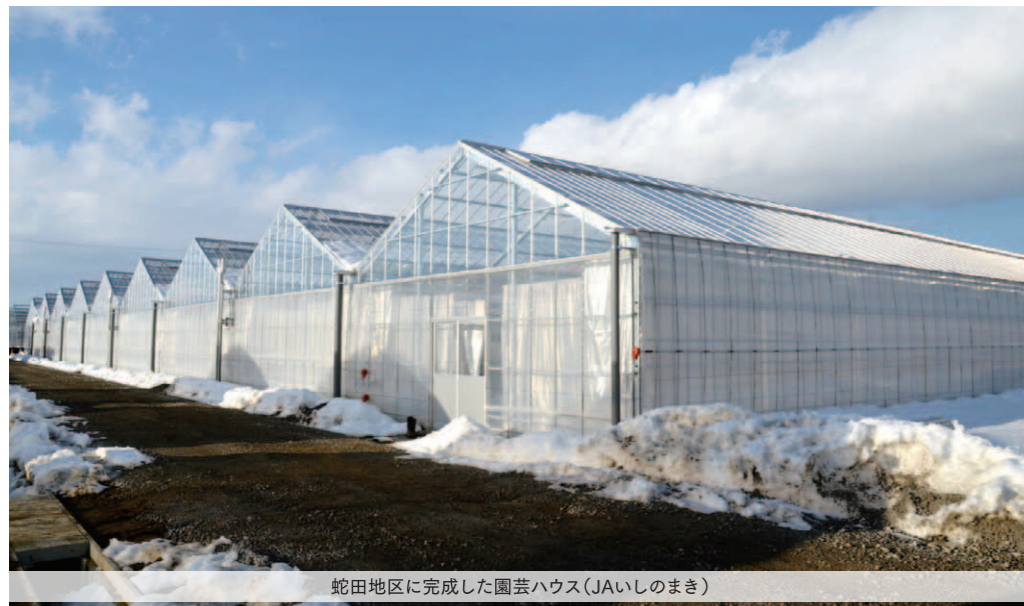
蛇田地区に完成した園芸ハウス(JAいしのまき)
