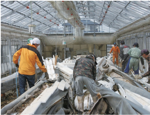
▲ロックウールの撤去作業をする職員と青年部員
