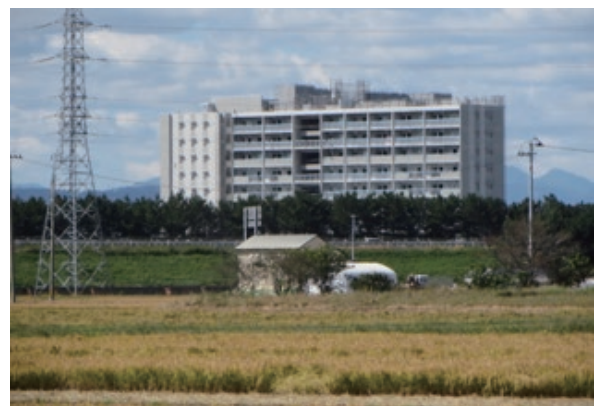
▲復興公営住宅、仙台市若林区
