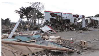
◀津波で復旧不可能となったJA野蒜給油所
