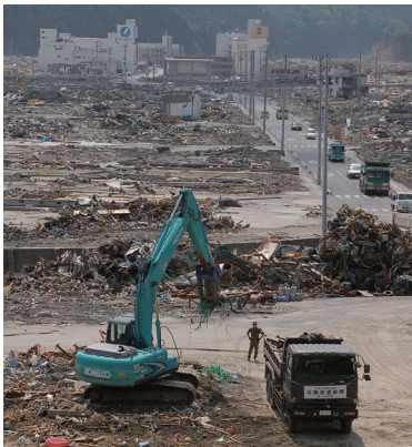
▲瓦礫・施設の撤去作業風景(南三陸)
