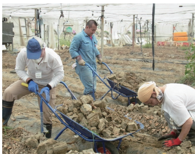
▲イチゴハウスの泥撤去
