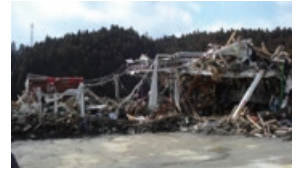
▲志津川セルフ給油所(震災直後)
