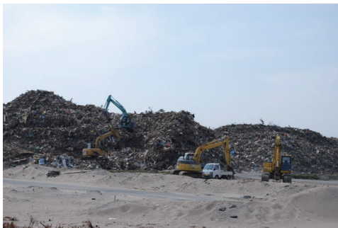
▲関係施設等の被害状況
