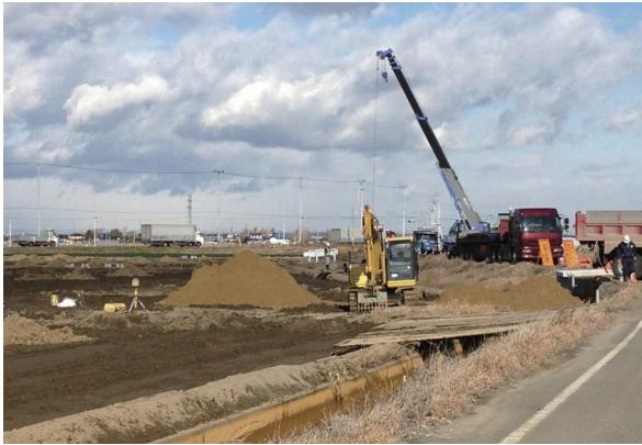
▲仙台市東部地域で進められる農地の復旧工事
