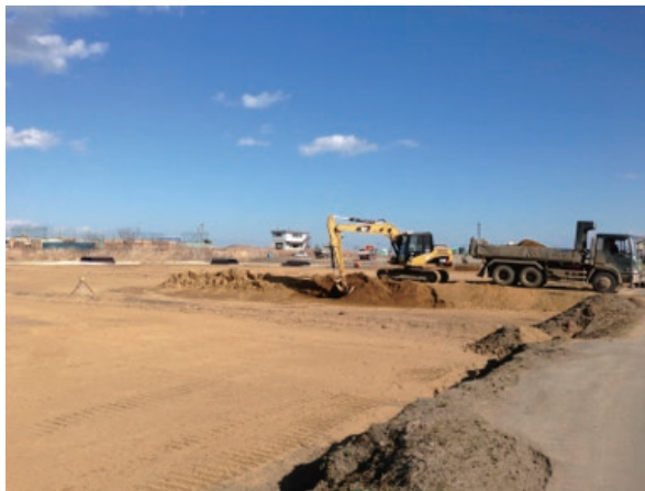
▲重機によるほ場整備、仙台市若林区
