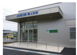
▲階上支店(地震被害により新築)
