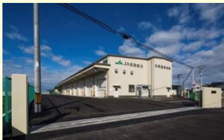
建設した玉浦の農業倉庫
